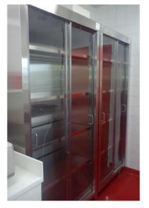
La partie basse est équipée d'un ou plusieurs bacs de rétention en cas de fuite d'un flacon.
